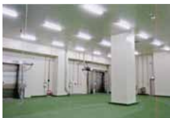
低温荷捌室 冷気流出、暖気流入対策を徹底考察した中で、横吹出しエアーカーテン採用。
